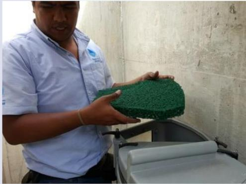
3- Retirar las matalas. Son 2 y se encuentran en la parte superior e inferior del módulo filtrante, entre las bolsas de medio. Si esta se encuentra en buen estado, se debe lavar con agua a presión para eliminar cualquier elemento que haya sido retenido durante el proceso de filtrado. En caso de que esto no sea posible, se requiere su cambio.
