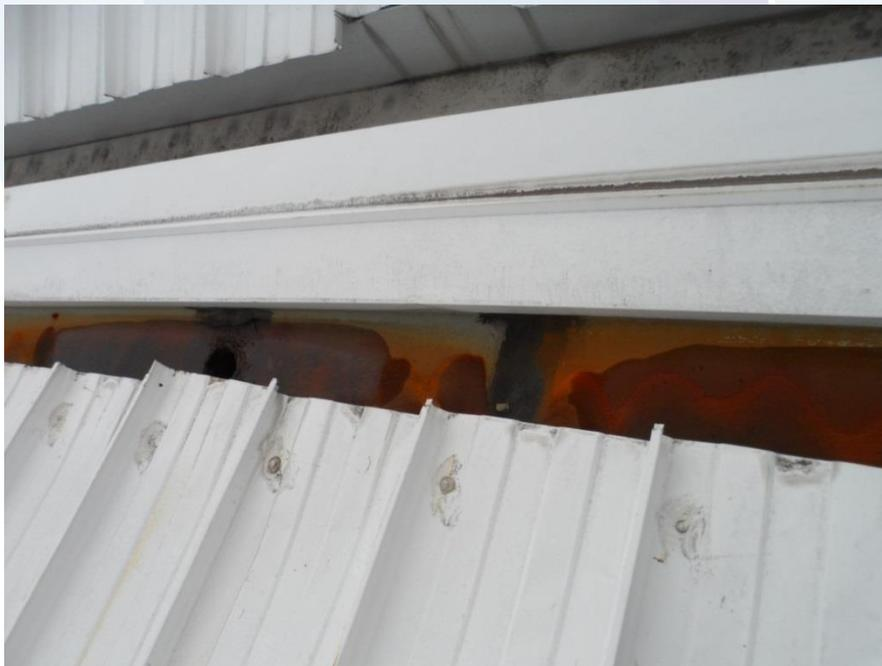
**Oxidación en canalones de bajadas pluviales.**
