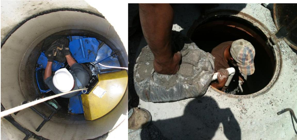
De igual forma, debe contar con un espacio central amplio que facilite el descenso para permitir que el personal de mantenimiento acceda de forma fácil y segura al cárcamo para remplazar las bolsas de medios filtrantes.
