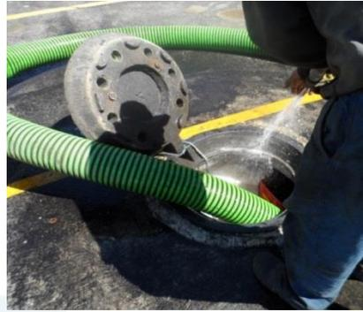
5- Se debe revisar que el módulo de drenado no se encuentre saturado, este se retira para darle una limpieza y en caso de que se observe que presenta obstrucción se requiere su remplazo. El cambio del dren es necesario, si en la inspección se observa que el nivel del agua al interior del cárcamo no alcanza al nivel de agua en la base de los medios filtrantes 36 horas después de una precipitación de 25 mm.
