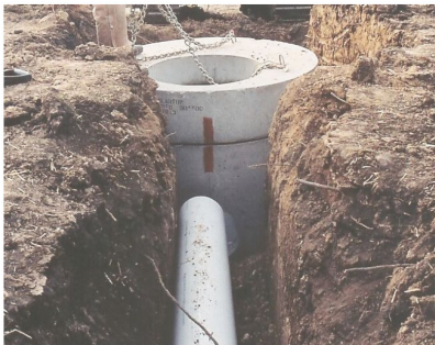
Haga Coincidir la Línea Marcada en la Tapa y el Tubo Vertical
