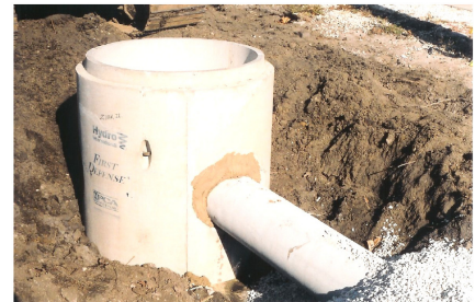
Tubería con Cemento Blanco Aplicado Apropiadamente
