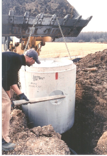
Descenso de Tubo Vertical para Colocarlo en la Base
