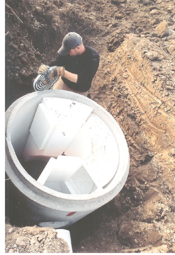
Aplicación de Sellador a Uniones
