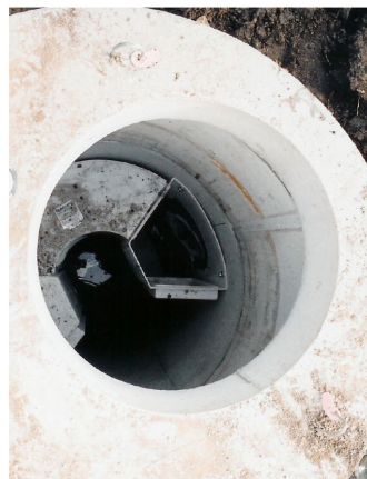
Orientación Adecuada del Acceso para Limpieza Encima de la Toma de Entrada
